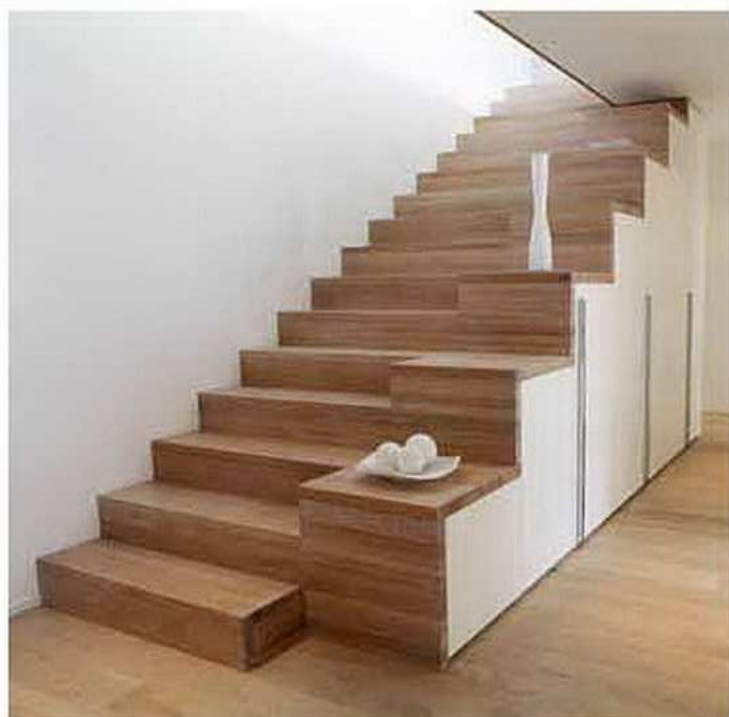
L'intégration d'une armoire sur le côté de l'escalier permet d'éviter de devoir mettre une barrière et élargit ainsi l'espace. Cet espace de rangement de 60 centimètres de profondeur crée une sorte de marche comme une rambarde de sécurité.
