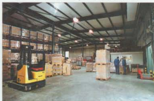
Ossature métallique et bardage en panneaux sandwich
